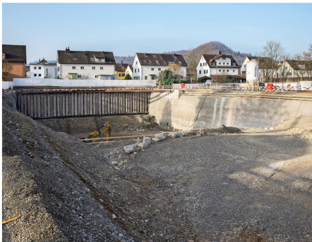
Statt Parkdeck und Sportwiese befindet sich bei der Kanti Baden eine riesige Baugrube für den Erweiterungsbau. Bild: Alex Spichale
